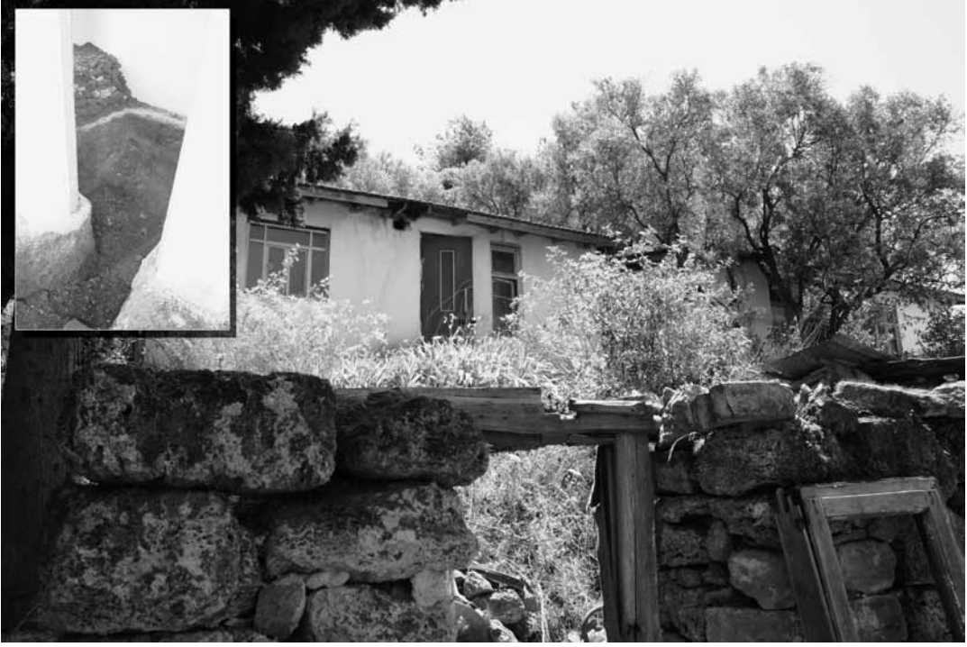
Aya Sotiri Kilisesi: Mudanya'ya bağlı Zeytinbağı kasabasında, Kumi Mevkii'nde yer alan Bizans kilisesinden geriye hiçbir şey kalmamış. Kilise tamamen yıkılmış ve üzerine derme çatma betonarme bir bina inşa edilmiş. Bu binayı inşaa eden kişi(ler) aynı zamanda kilisenin içinde ve çevresinde çok sayıda kaçak kazı yapmış. Bugün boş olan binaların içinde derin defneci çukurları görülmekte
